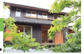
びわ湖材を使用した住宅
