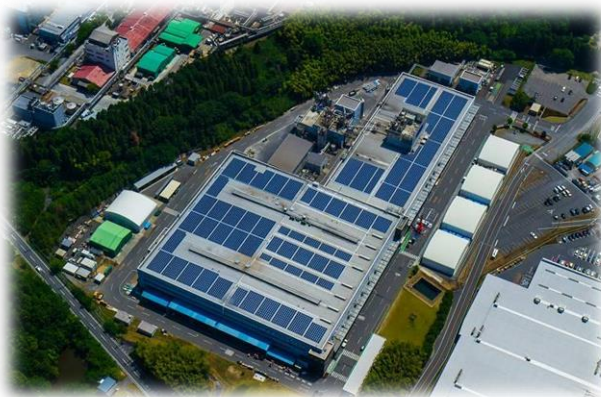
セキスイボード(株) 【甲賀市：1.0MW】
