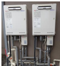
→ガス給湯器との接続
