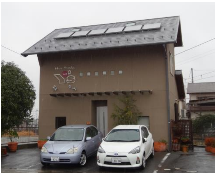
屋根に設置された太陽熱集熱パネル
