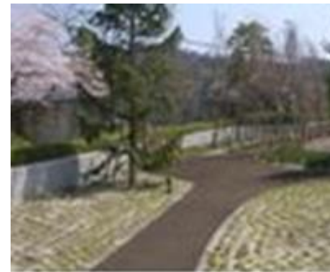
建設現場で発生する廃木材等を使用した遊歩道舗装材
